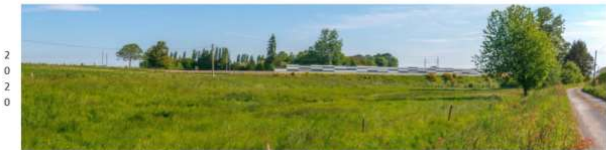
35 - Louvigné-de-Bais - "Basse-Haie-D'Y" : transformation du paysage par la disparition du bâti et de l'alignement de peupliers, et par l'insertion du remblai végétalisé de la LGV et de murs anti-bruit
