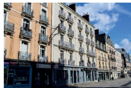
Logements collectifs près de la gare de Rennes. Crédit photo : ESO Le Mans.
