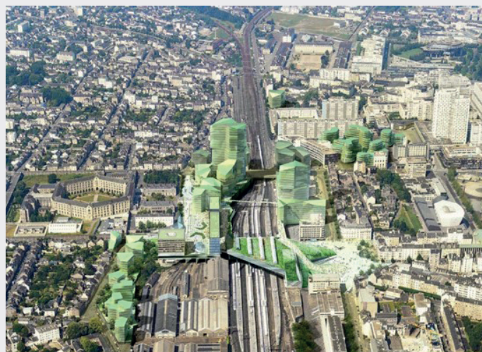
Vue aérienne du projet EuroRennes. Crédit photo : FGP Philippe Gazeau et Louis Paillard.
