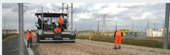
Préballastage par finishers
